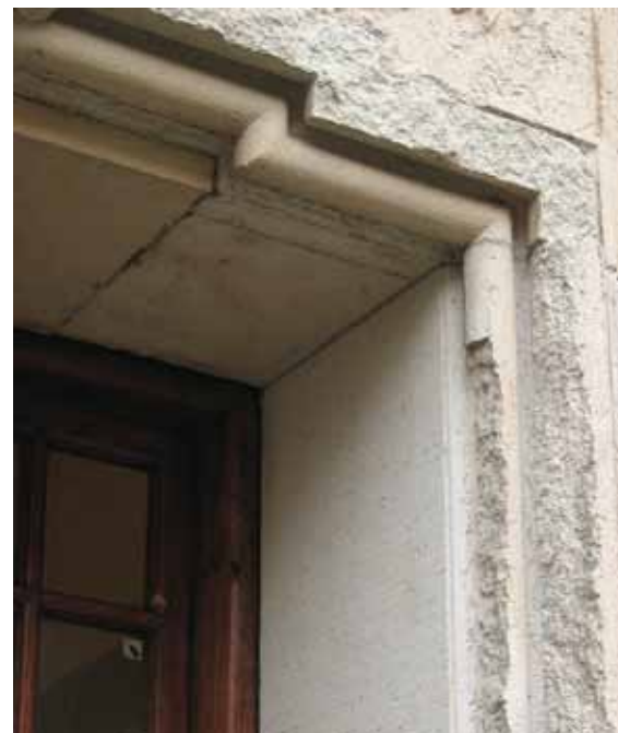
Fig 3.18 Stora materialförluster på grund av klovförsvagn. Högbergsgatan 11, Stockholm.
