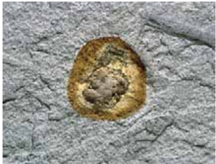
Fig 3.11 Rostande pyritklump i gotländsk sandsten. Vamlingbo kyrka, Gotland
