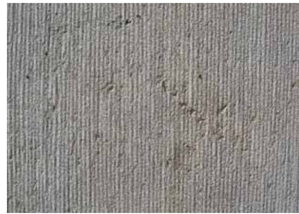
Fig 7.9 Skrädhuggen kalstensyta. Rosenbad, Stockholm
