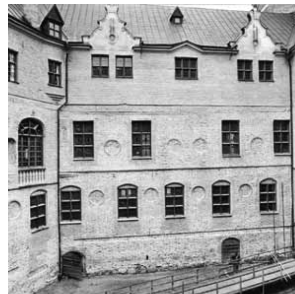
Fig 1.58 Gripsholms slott från sekelskiftet 1900, efter Fredrik Lilljekvist restaurering. Långorna har byggts på med ett våningsplan. Fasaden har fått en ljus puts med dekor kring fönstren och under takfoten. Den grova putsrustiken har kopierats efter Kung Jans port på Uppsala slott.
