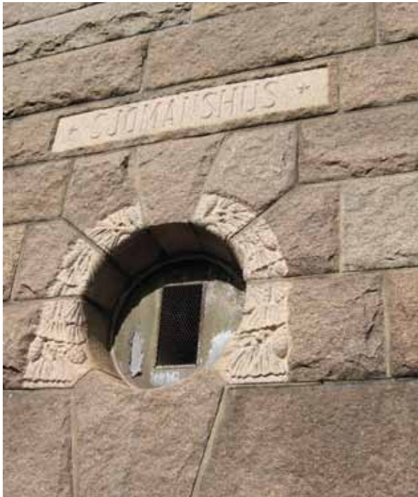
Fig 7.5 Råkoppsmur av granit med dekor och namntavla fint krysshamrade. Sjömanshuset, Lysekil.
