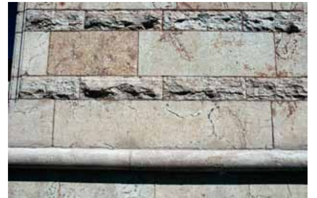
Fig 7.14 Fasad av röd kalksten med tandhuggen yta omväxlande med dubbelstucken. Strandvägen 53, Stockholm
