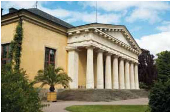
Fig 1.21 Botanikum i Uppsala exemplifierar det sena 1700-talets antikintresse. Mot en gulputsad slät fasad står en tempelportik i gotländsk målad sandsten, sockeln är huvudsakligen i granit. Portomfattningar, fönsteromfattningar och trappa av Roslagssandsten.
