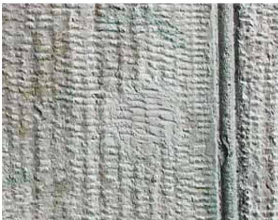
Fig 4.14 Lagning av håll och ytbearbetning som liknar befintlig sten. Storgatan, Stockholm.
