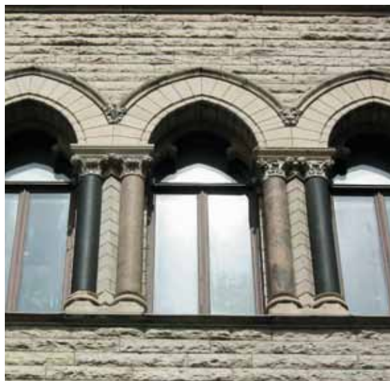
Fig 1.23 Fasaden får sin dekorativa verkan av stenens kontrasterande stensorter med olika kulörer och bearbetning. Murverk av ljus kalksten. Mellan fönstren kolonner av svart och röd granit. Munkbron 9 i Stockholm.
