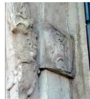
Fig 3.22 Sandnings- och exfolieringsskador Gotlandssandsten(karbonatbunden). Petersenska huset, Munkbron, Stockholm.
