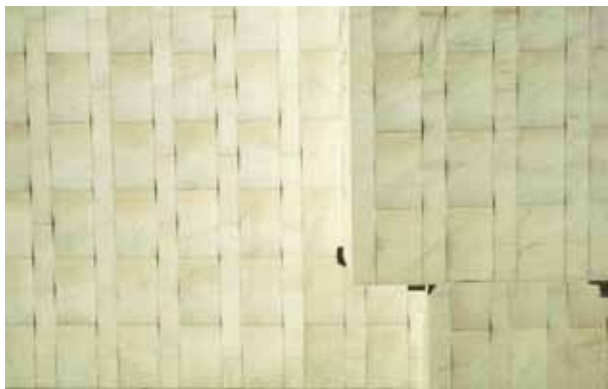
Fig 1.35 Finlandiahusets Carraramarmor visar böjningsskador och smutsmärken i ett rutnät som inte var avsedd i Alvar Aaltos arkitektur.
