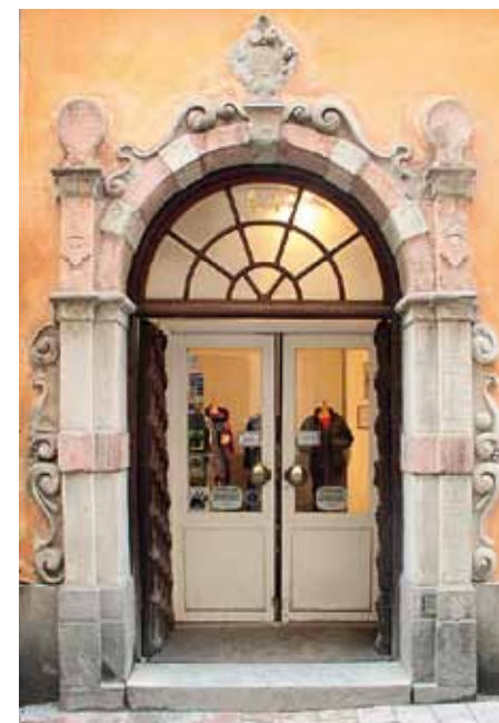
Fig 1.18 Portal 1600-tal. Renässansens ornamentik fick fortsatt användning under barockens epok. Denna portal visar en polykrom stenarkitektur med omväxlande röd kalksten och grå sandsten. Västerlånggatan 64, Stockholm.
