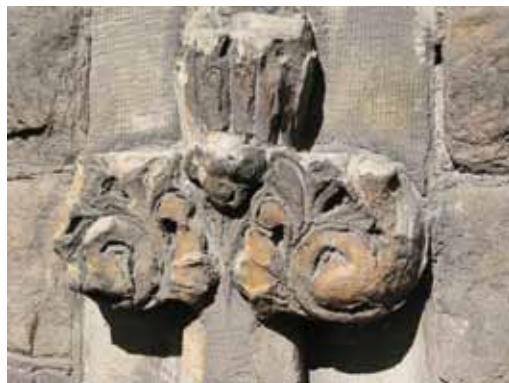
Fig 3.17 Tunn krusta på gotländsk sandsten. Kv Matrosen, Stockholm.
