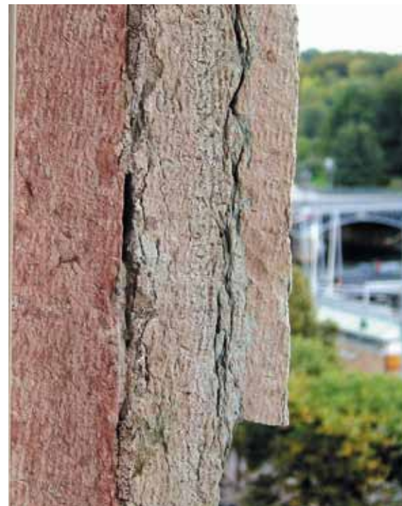
Fig 3.19 Kalksten med vertikala klov medför att stenen klyvs. Strandvägen, Stockholm.
