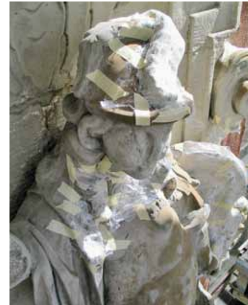
Fig 4.6 Partiell lerinpackning. Petersénska huset, Munkbron, Stockholm.
