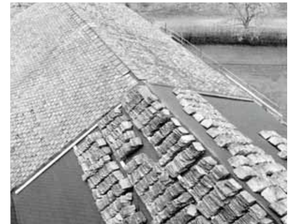
Fig 5.7 Omläggning av skiffertak på Frykeruds kyrka i Värmland 1993. Skifferraderna linjeras upp med snören. Skiffern spikas i hak.
