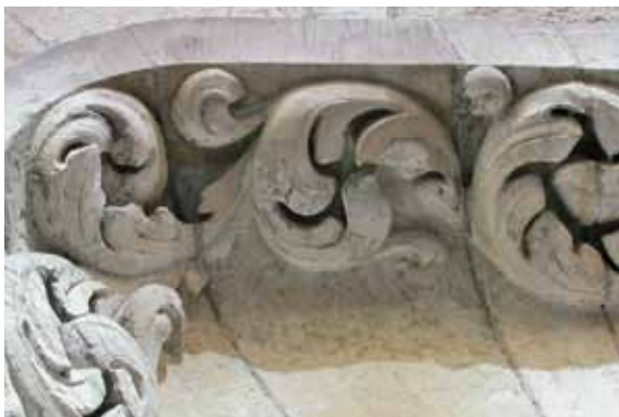
Fig 4.13 Lagning med rekonstruktion av skadat bladverk och listkant. Portal i kalksten, Vidargatan, Stockholm. Foto taget ca tio år efter utförandet.
