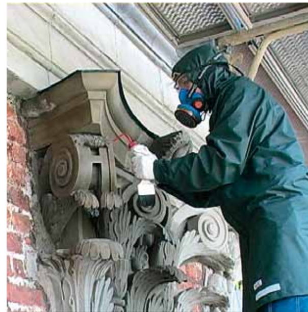
Fig 4.9 Konsolidering med kiselsyraester. Riddarhuset, Stockholm
