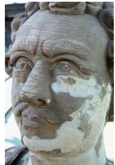
Fig 1.61 Skulptur, Riddarhusets tak, södra sidan, av gotländsk sandsten. Behandlad med kasein första halvan av 1900-talet. Det behandlade ytskiktet krackelerar och spjälkas.
