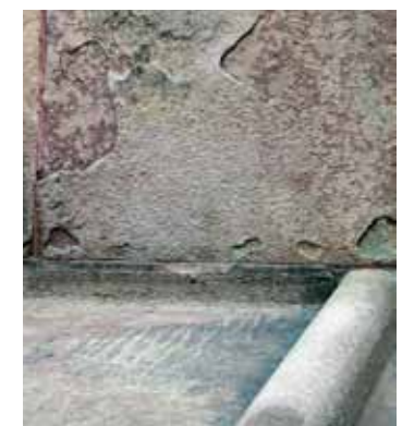
Fig 3.21 Exfolieringsskador, Roslagssandsten (kvarsitbunden). Storkyrkan, Stockholm.
