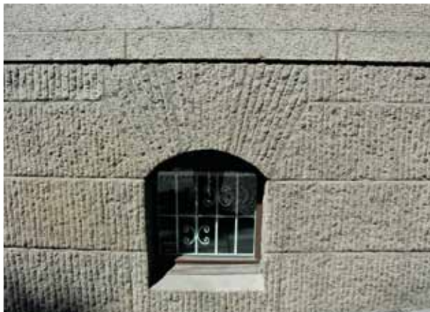
Fig 7.6 Sockel av randmejslad granit. Ovanför sockeln är graniten krysshamrad, grad 1. Eriksbergsgatan 44, Stockholm.
