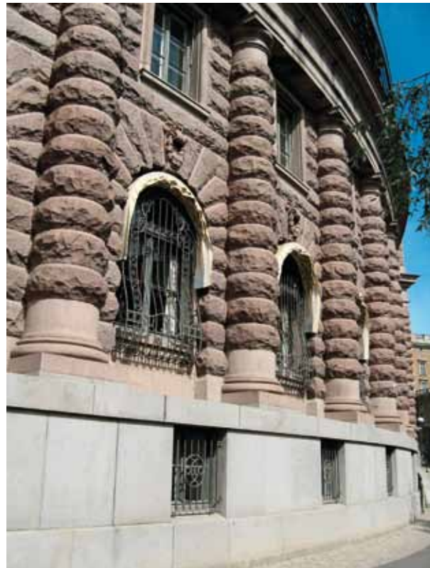
Fig 7.7 Riksdagshuset, f d Riksbanken, Stockholm. Sockel av grå räffelhamrad granit. Murverk i röd granit med råköpp. Blocken har kantslag vid fogarna. Pilastrarnas baser och kapitäl är krysshamrade.
