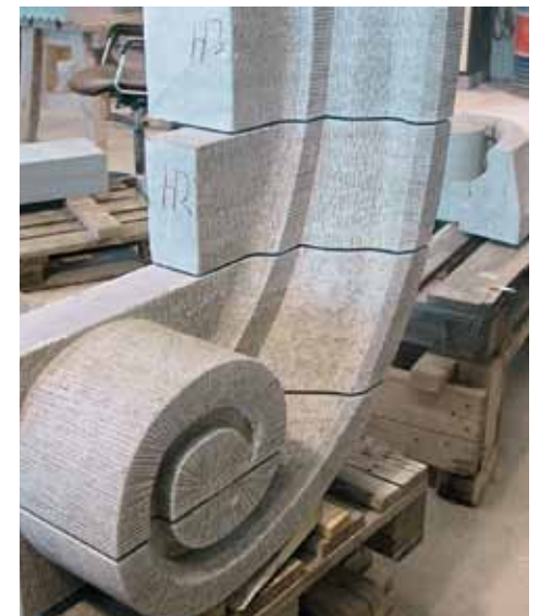
Fig 4.18 Den nyhuggna voluten och del av nytt krön inne på verkstaden.
