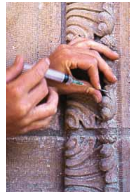
Fig 4.3 Säkring genom injektlimning. Gamla Krematoriet, Örebro.
