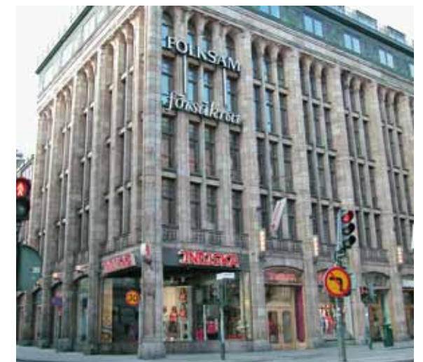
Fig 1.27 Affärs- och kontorshus på Kungsgatan i Stockholm byggt 1910 som en skelettkonstruktion av armerad betong, med tillagd fasad av Grännasandsten. Glaspartierna ramas in av smala pelare och bjälklagsmarkeringar av sandsten.
