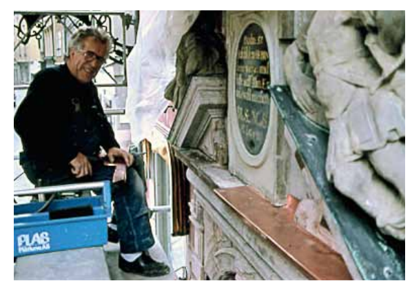
Fig 4.24 Avtäckning med kopparplåt på gesims, Stortorget i Stockholm.
