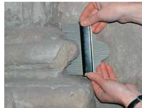
Fig 4.2 Vid mallning med profilkam måste man ha klart för sig att den vittrade stenen inte ger rätt profil. Måttan måste justeras till ursprunglig form. Mallprofilen bör godkännas av antikvarisk kontrollant.
