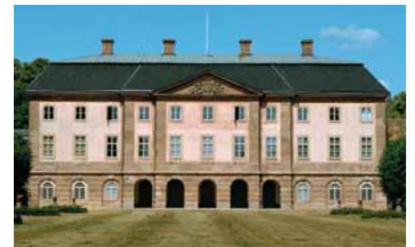
Fig 1.20 Övedsklosters slott, ritat av Carl Hårleman och uppfört under 1760-talet. Rokokons fasader är ofta försiktigt modulerade med risaliter. Mot den rosa putsade fasaden står souterrängvåning, lisener, fronton och takgesims av lokal röd Övedssandsten.
