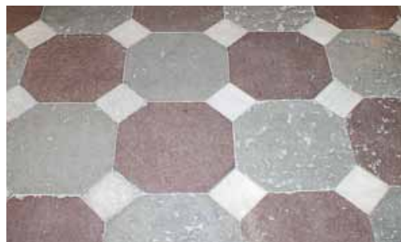
Fig 1.44 Mönsterlagt stengolv med olika sorters marmor och kalksten från sent 1800-tal.
