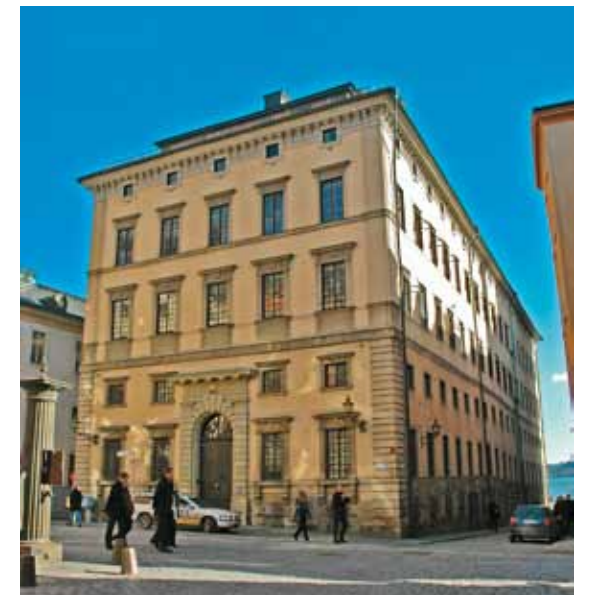
Fig 1.19 Södra Bancohuset vid Järntorget i Stockholm uppfört 1676-80 efter N. Tessin d.ä:s ritningar. Byggnaden, i målad gotländsk sandsten och med putsad fasad, har sin förebild i den romerska barocken. Den är senare tillbyggd mot öster.
